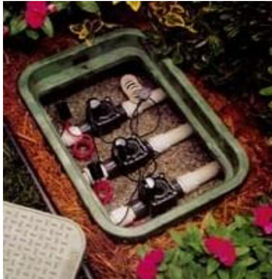
Preko solenoida (špule) na vrhu ventila primaju signal za otvaranje / zatvaranje od programatora.
