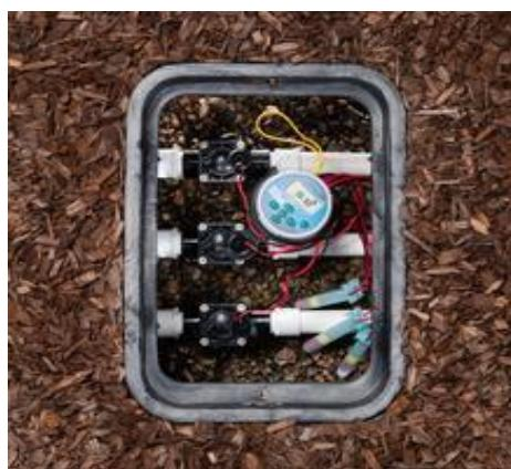
Programator Node smješta se u ventilsku kutiju uz ventile. Ima čvrsti zaštitni gumeni pokrov za zaštitu od vlage. Preko posebnog nosača, koji je u kompletu sa programatorom učvrsti se za solenoid (špulu) ventila ili na stranicu ventiliskog okna.
